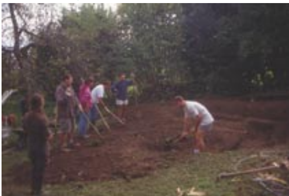
Un chantier, Gruffy, Haute-Savoie
