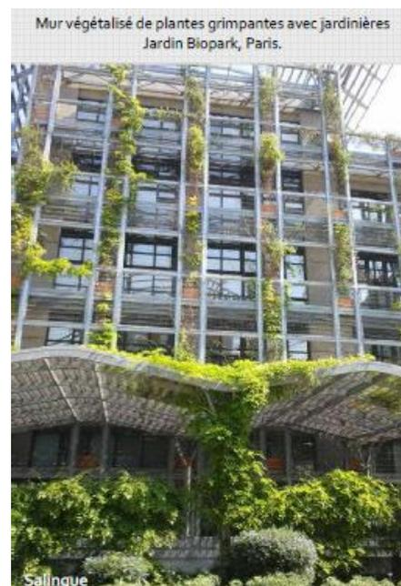
**Mur complexe:** comporte la plupart du temps une structure fixée à l'avant du mur du bâtiment, dédiée à maintenir le substrat pour l'installation et la survie des végétaux
