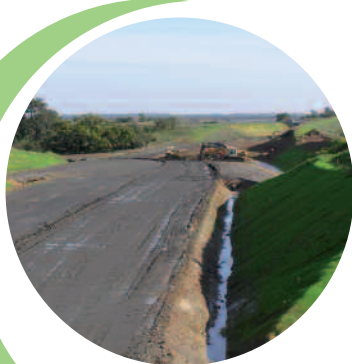
Sol imperméabilisé © A. Bispo, ADEME
