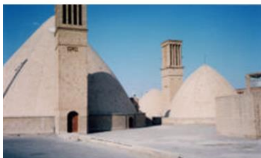
Tour à vent et réservoir d'eau (Perse-Iran)
